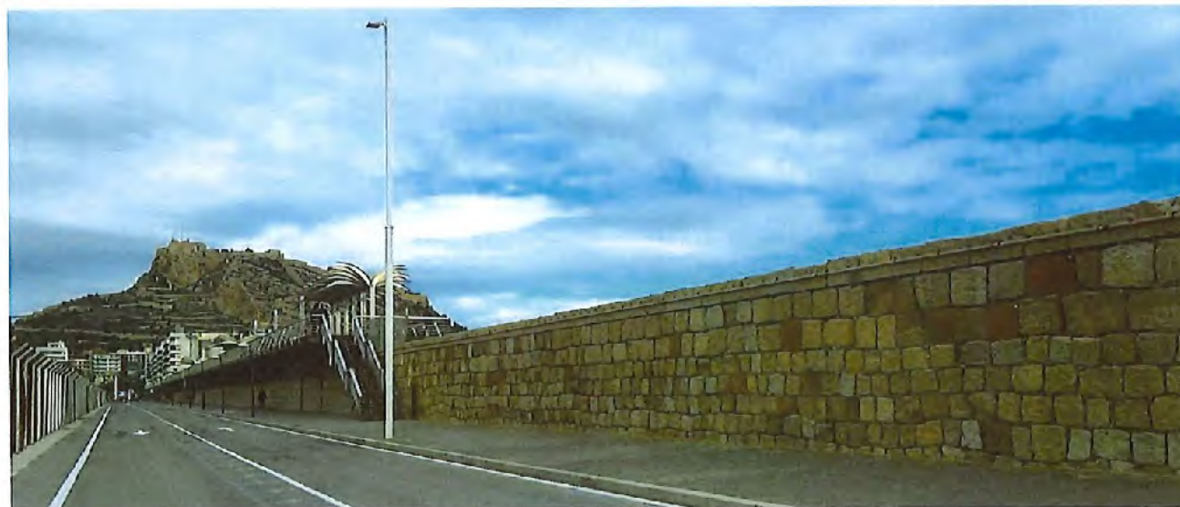
Figura 27. Vista general del Dique de Levante (muelle 12) desde el Sur
