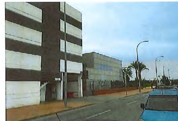
Figura 13. Vista parcial del parking desde el Suroeste, con el edificio de la Capitanía Marítima en el centro de la imagen.
