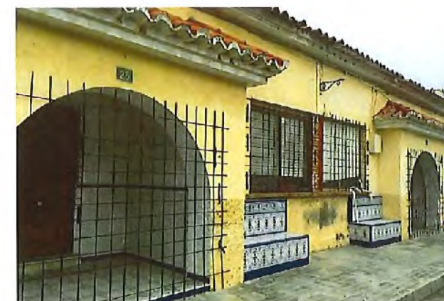
Figura 18. Detalle de los accesos cerrados a dos viviendas del barrio Heliodoro Madrona.
