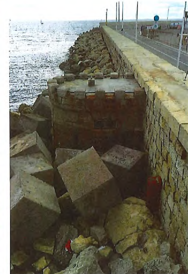
Figura 30. Vista del mareógrafo Alicante 2 adosado al Dique de Levante.
