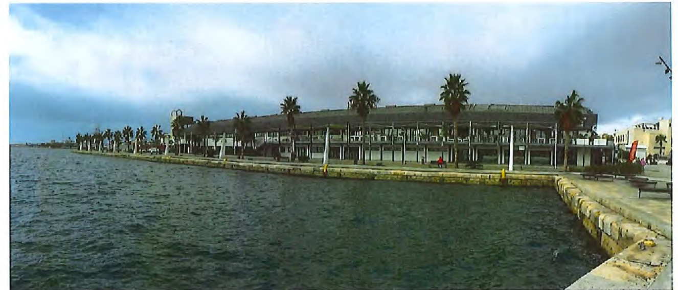
Figura 21. Vista general desde el Sureste del muelle 10.
