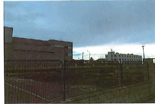
Figura 12. Vista desde el Noroeste de las parcelas al Oeste de la C/ Muelle de Poniente, con la fachada trasera del Instituto Social de la Marina a la izquierda.
