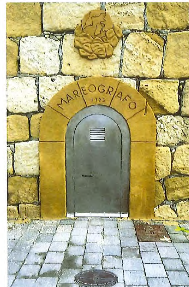
Figura 29. Detalle del acceso al mareógrafo Alicante 2.
