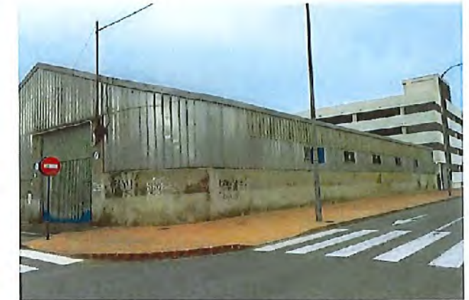
Figura 14. Vista parcial desde el Suroeste de la manzana con la nave industrial, con el parking al fondo de la imagen.
