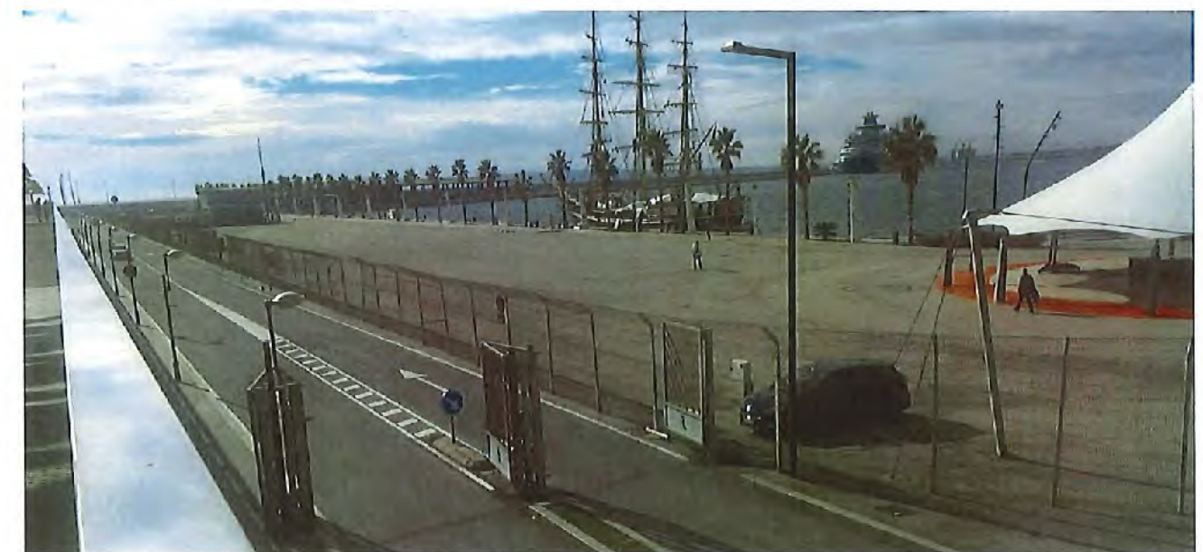
Figura 21. Vista general desde el Norte del muelle 12.
