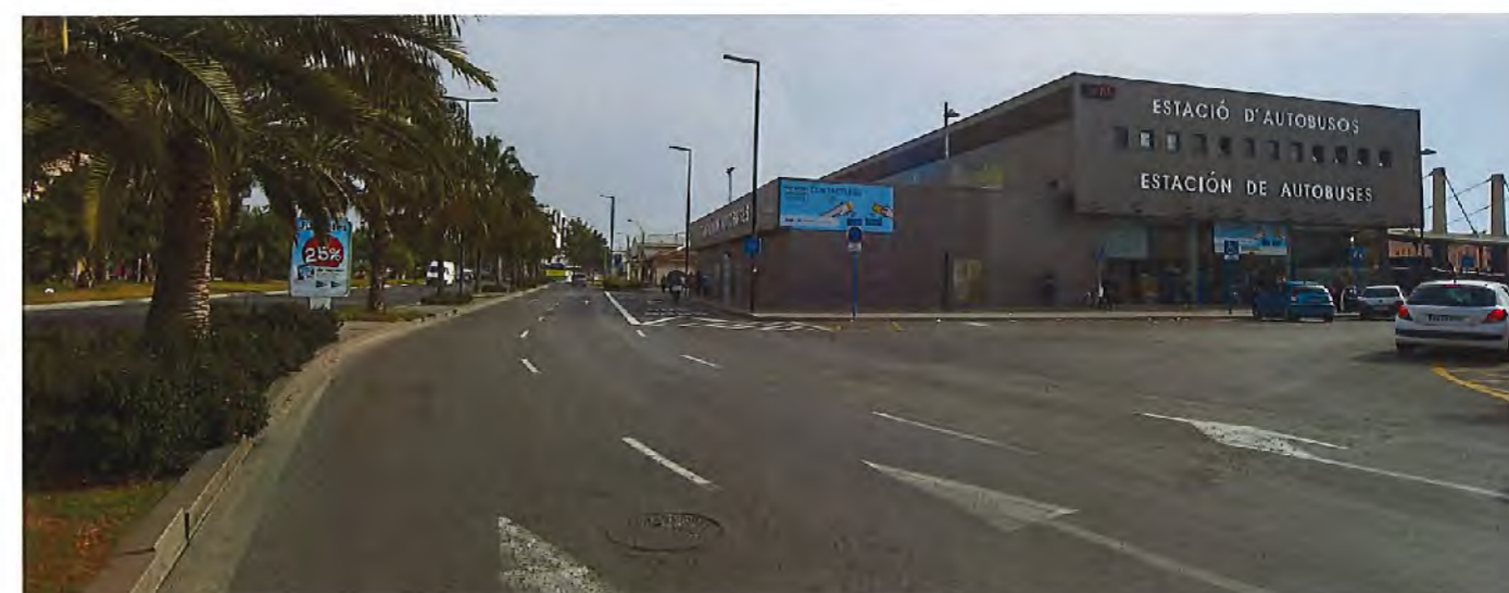
Estación de autobuses en la Zona I del Sector 3MP (ámbito de actuación)
